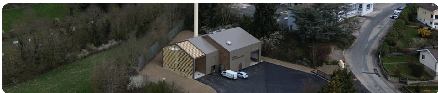
Chaufferie biomasse de Saint-Symphorien-sur-Coise
