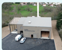
Chaufferie de Saint Symphorien sur Coise
