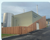
Chaufferie de Loire sur Rhône
