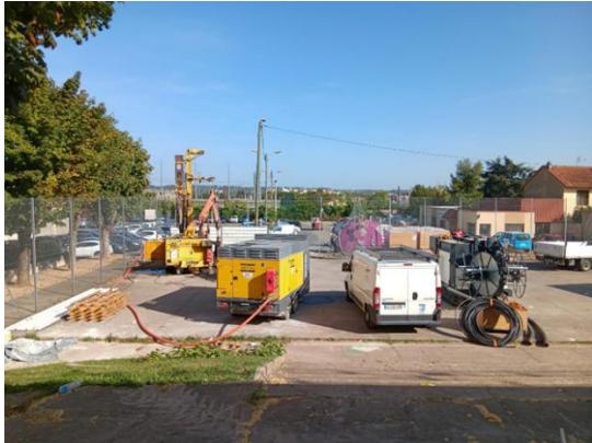
Travaux de forage géothermique
