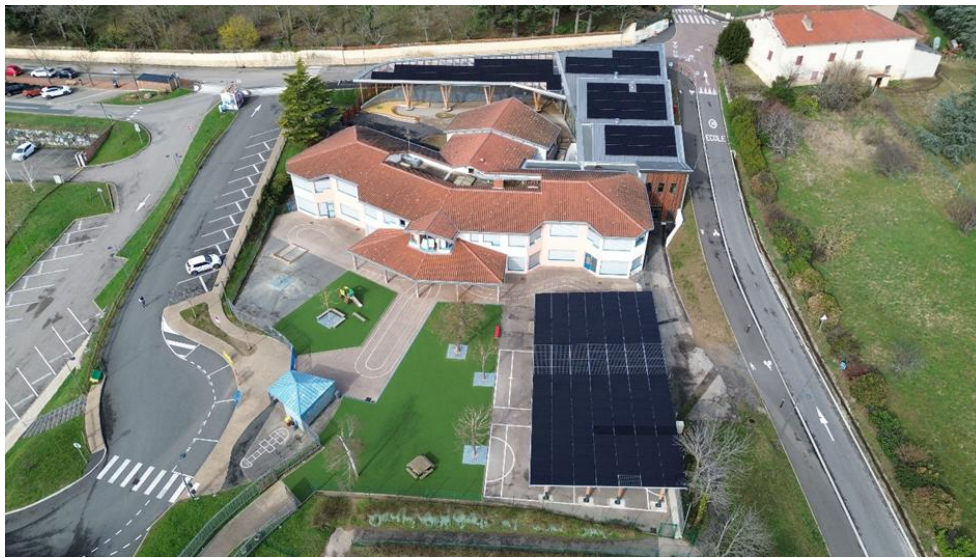
Vue aérienne des installations photovoltaïques du SYDER sur le groupe scolaire de Pollionnay
