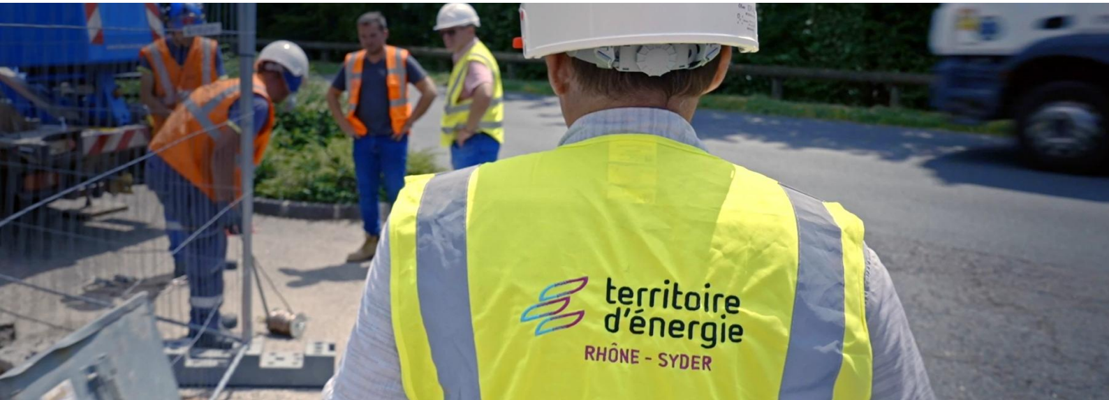
Intervention du SYDER sur les réseaux électriques
