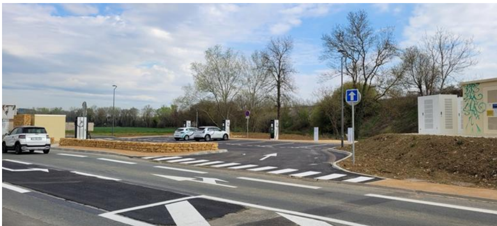
Station publique de recharge haute puissance du SYDER à Ambérieux-d 'Azergues
