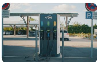
Cet engagement pour la transition énergétique s'illustre également par la présence sur le site d'une borne de recharge rapide 50 kW pour véhicules électriques, capable de charger deux voitures simultanément.
