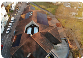
Vue aérienne de l'installation photovoltaïque sur le toit de l'école de la commune de Soucieux-les-Mines
