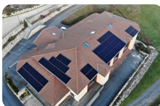
Vue aérienne de l'installation photovoltaïque sur le toit de la salle des fêtes de la commune de Saint-Julien-sur-Bibost
