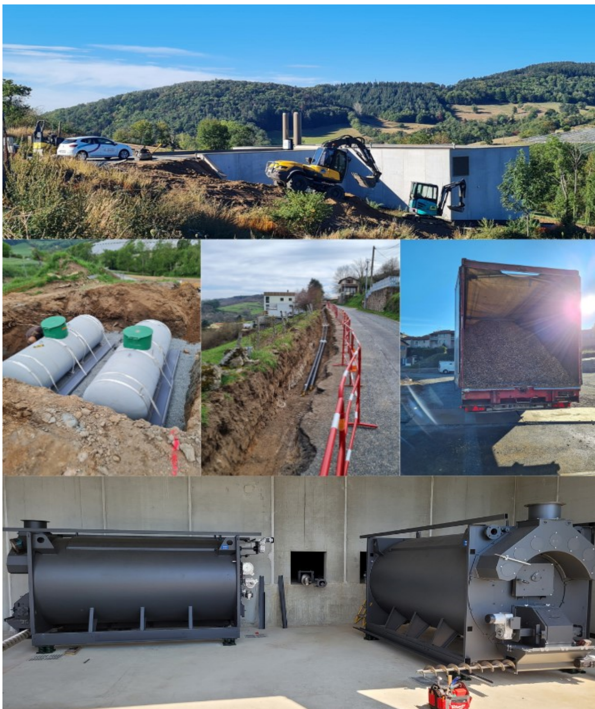
Photos de la création du réseau de chaleur de Montrottier en 2023.
