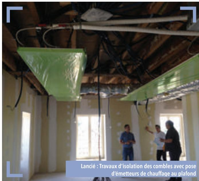
Lancé : Travaux d'isolation des combles avec pose d'émetteurs de chauffage au plafond
